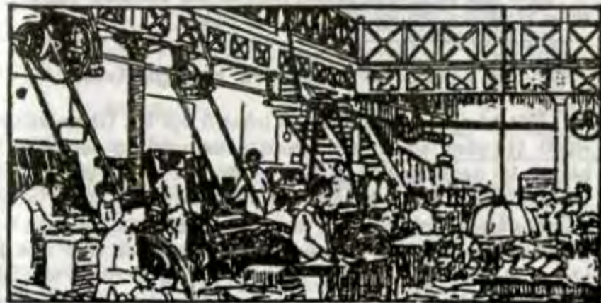
Nhà máy hơi.
