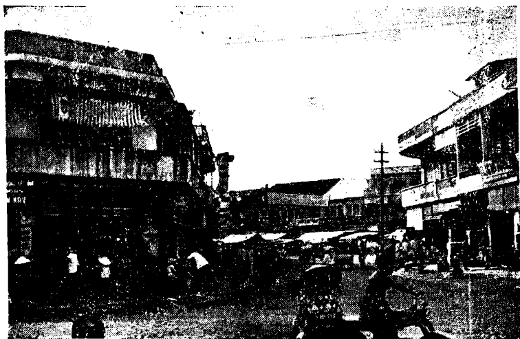
Đường rộn dịp nhất Tỉnh Mỹ
