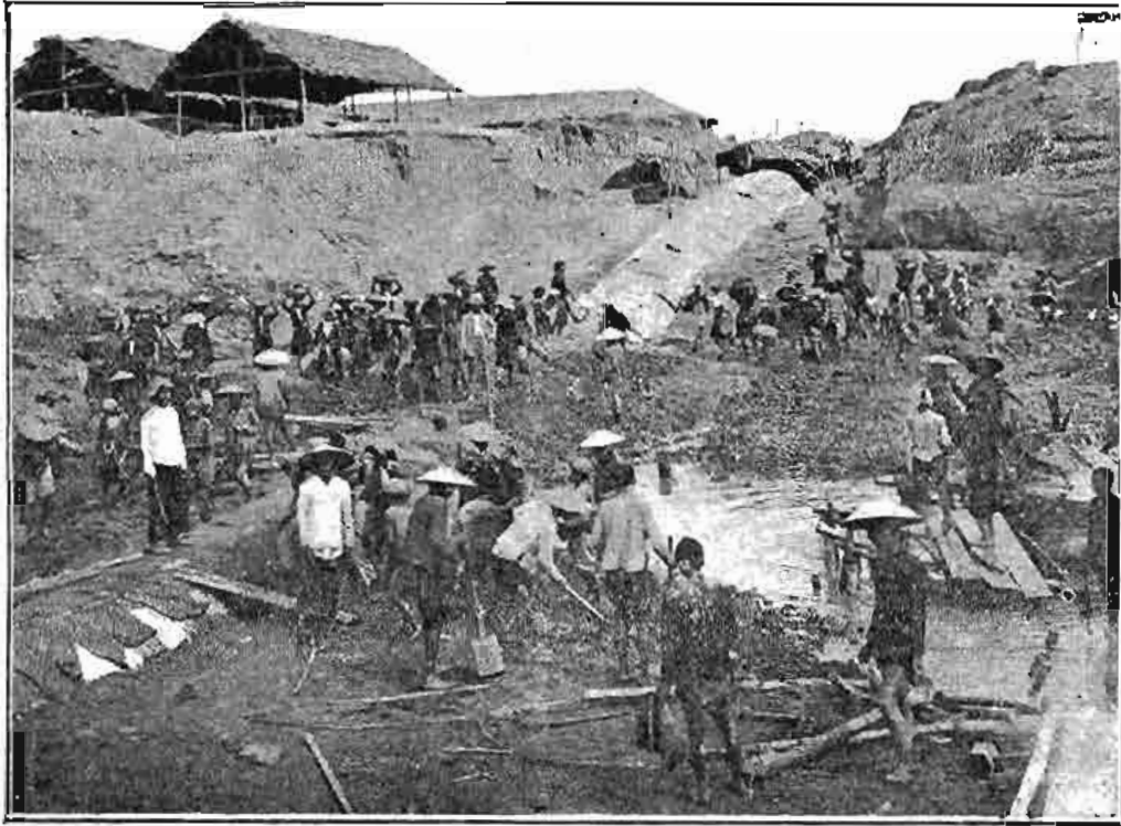
Công ngầm giã nước ở Vũ-di (Thần công đã xây xong, đang lập đất cho tới đây sông cũ đã bớt tạm đi trước).
