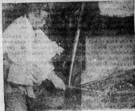
Trước khi đem ngâm vào một hồ nước lấy ở trong lòng đất lên, thanh kiếm được nung rèn nhiều lần bởi tay người thợ
