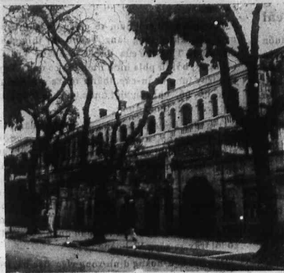
Photo Vũ-an-Ninh Dãy nhà hai tầng ở phố Richard bên cạnh nhà thờ hương gọi là «đầy Cổ Tư Hồng»
