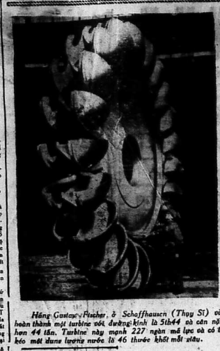
Hãng Garmy-Fischer & Schaffhausen (Thụy Sĩ) vừa hoàn thành một turbine có đường kính là 5144 x 60 năm nay... Hãng Garmy-Fischer & Schaffhausen (Thụy Sĩ) vừa hoàn thành một turbine có đường kính là 5144 x 60 năm nay...
