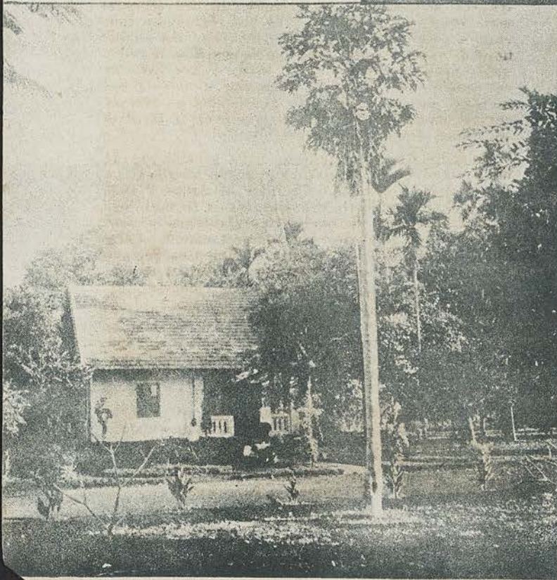
Maison de surveillant.
