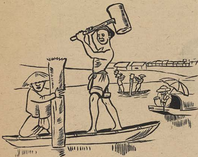
Le 5 e jour on enfonça les pieux.
