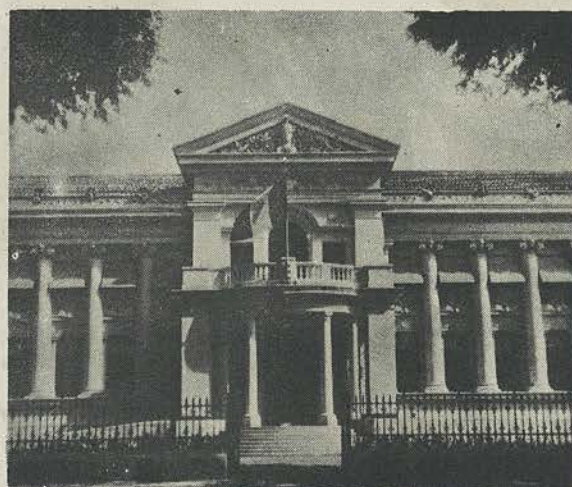
Façade après transformation.
