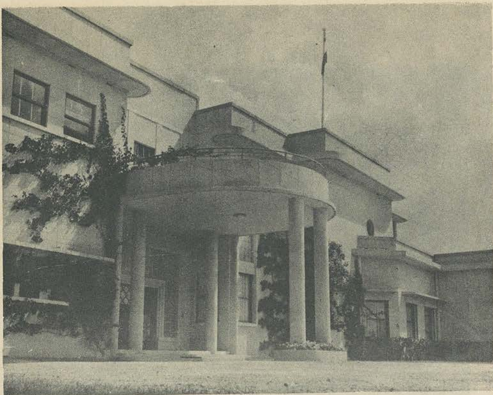
Façade sur l'entrée.
