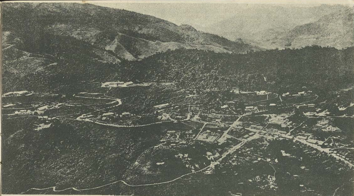
CHAPA (Vue aérienne).
