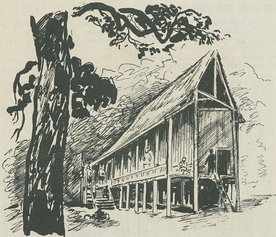
Première partie de la maison du poste de Luang-Prabang (1890).
