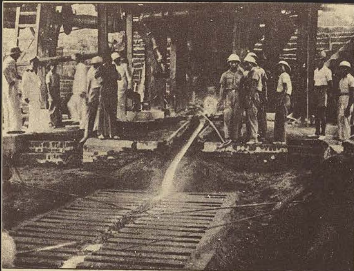
La coulée de la fonte.
