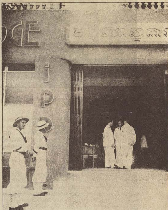
↑ ENTRÉE DU HALL D'INFORMATION
