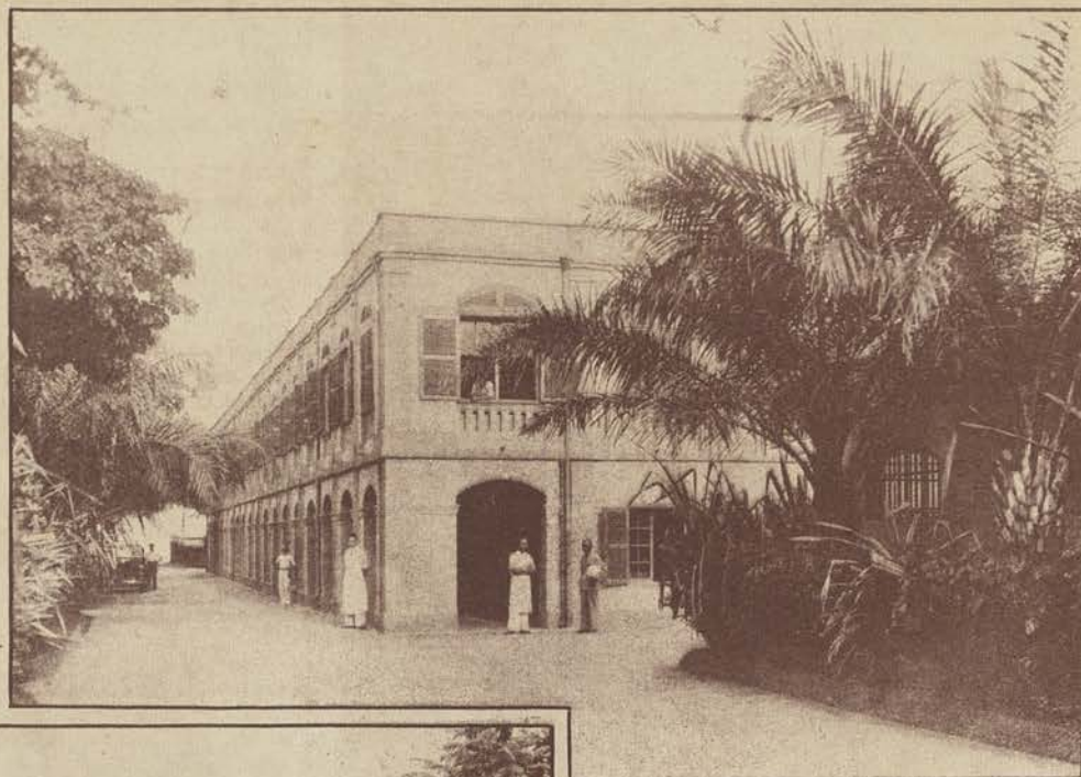
Le bâtiment principal.
