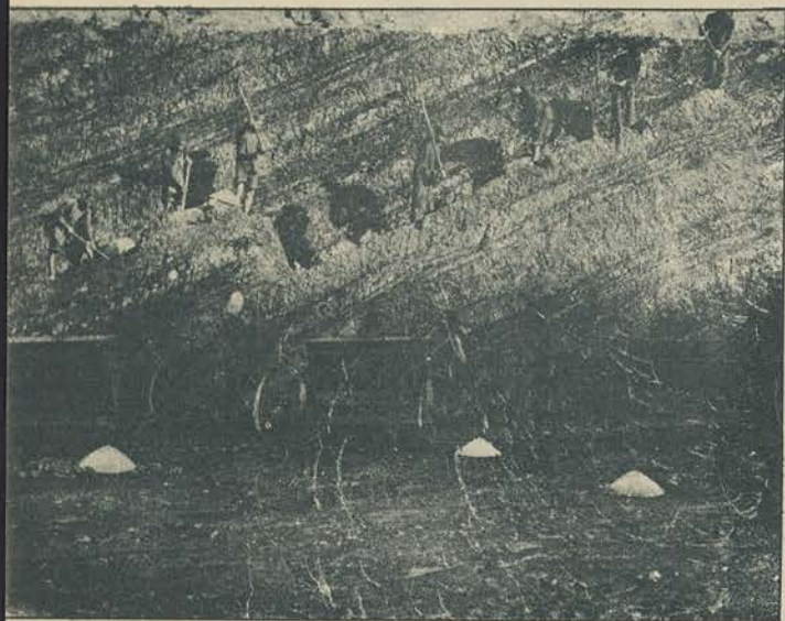
HALAM. — Coolies sur le gradin.
