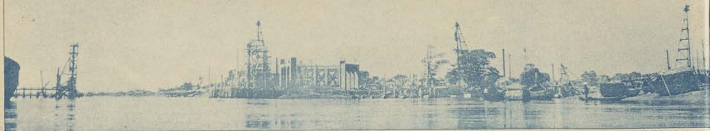
1939 : les travaux commencent. — Vue prise à l'aval de l' "îlot industriel", dont on voit au centre la pointe. A gauche : le canal de doublement ; à droite : l'Arroyo Chinois.
