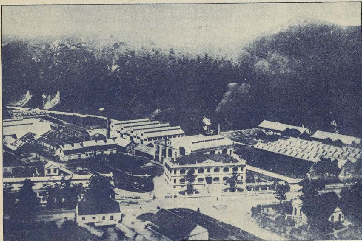
Vue générale des Usines de Benthuy
