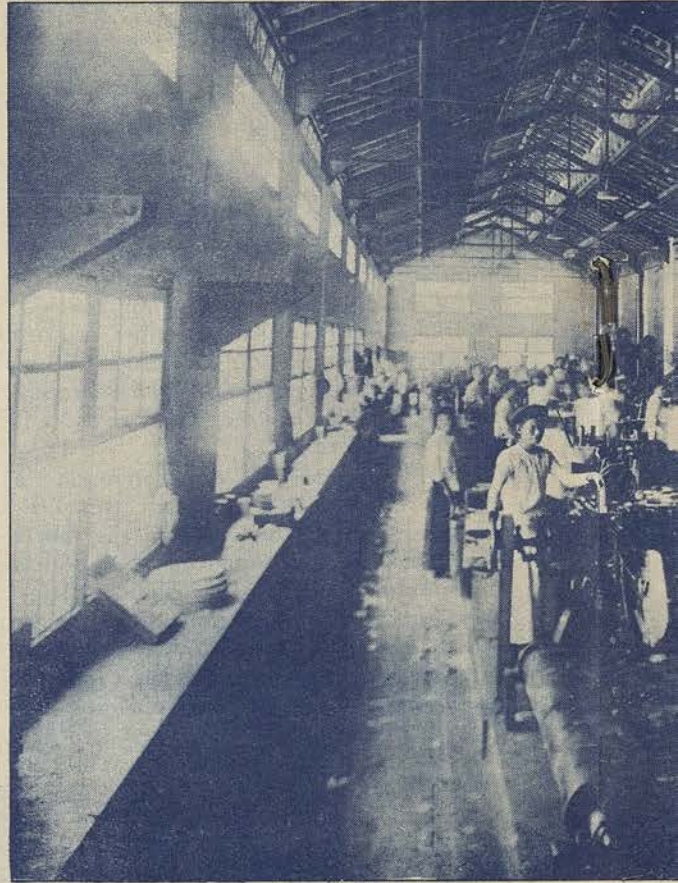
Salle de fabrication des boîtes. — A droite, les tiges sont alignées sur des plateaux où elles se présentent serrées, et de champ. — A gauche, les femmes enlèvent au passage des objets manqués. Même fabrication pour l'extérieur de la boîte. L'intérieur de boîte est fabriqué par la machine, à la cadence de 90 à 100 à la minute. L'extérieur à la cadence de 120 à 130.
