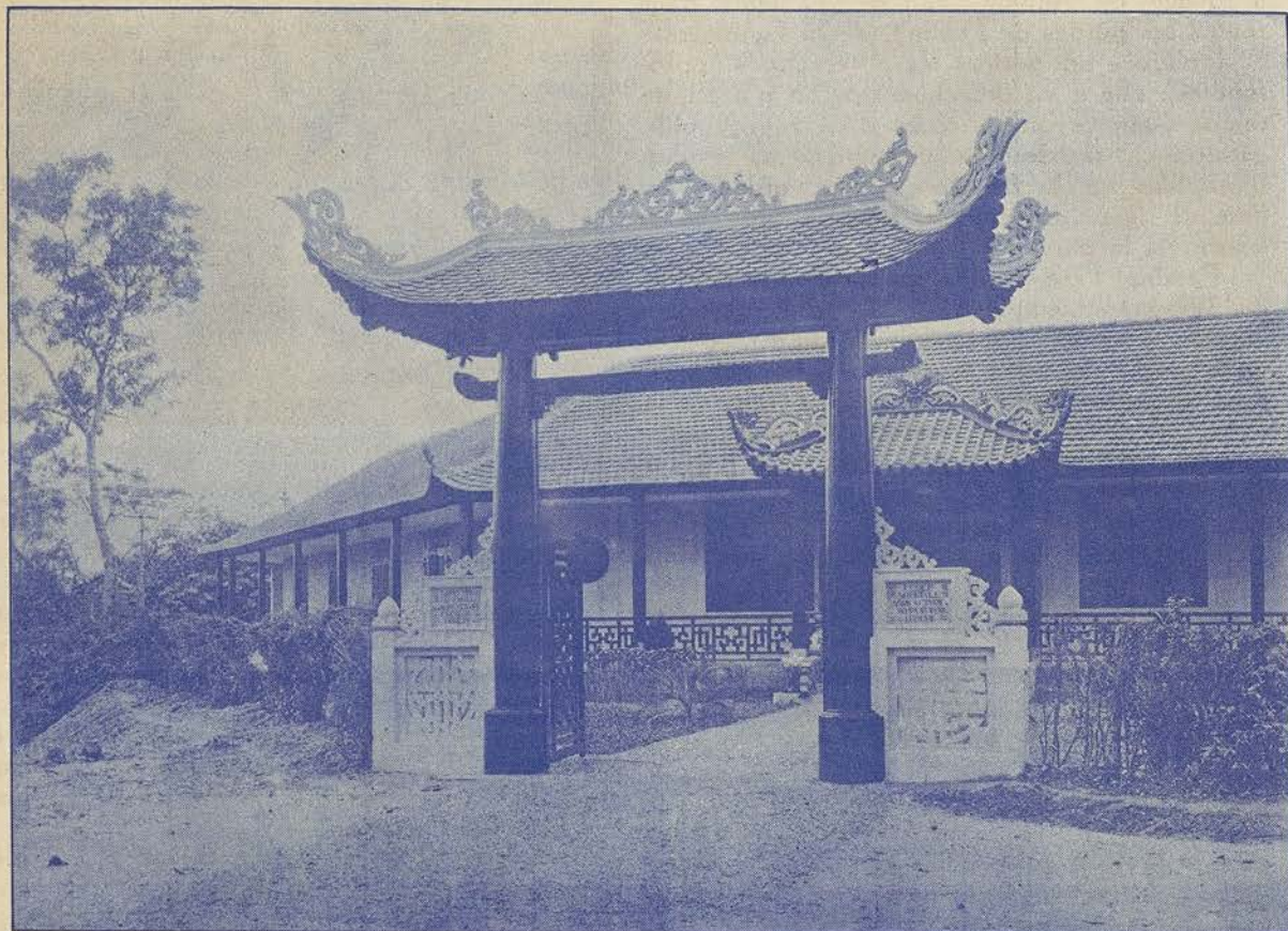
Le portique d'entrée
