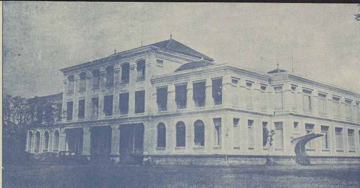
Les Bureaux de la Résidence Supérieure.
