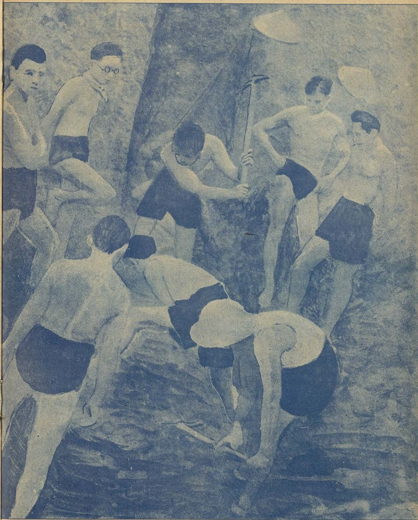
Barrage d'un torrent pour la construction d'une piscine
