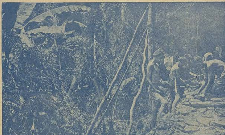
Construction de la route qui traverse le camp
