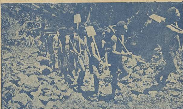
Le retour du travail au chantier de la piscine
