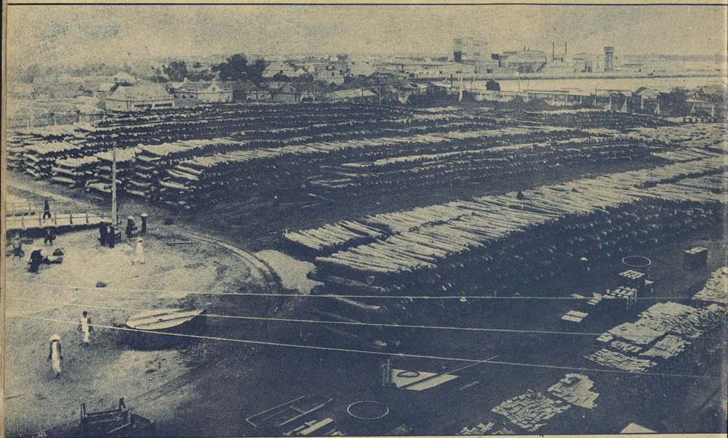
Stock de bois en grume pour la fabrication des barils
