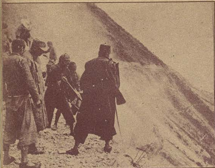
Après un glissement de terrain, on dégage la route.
