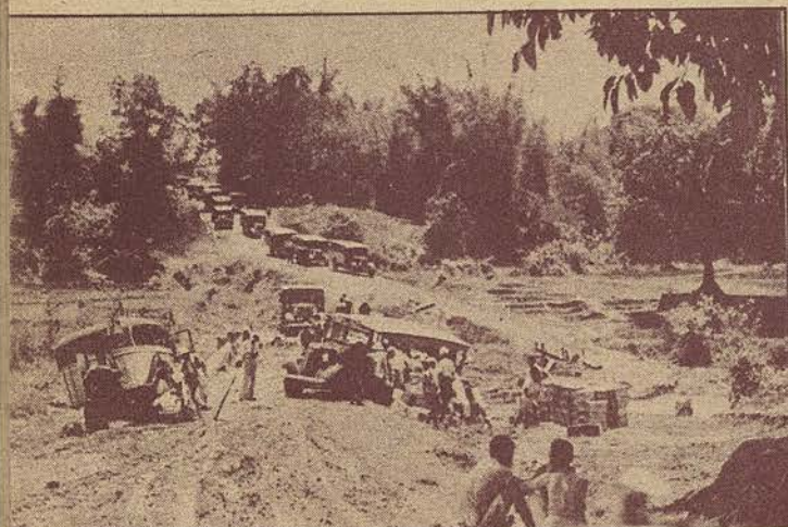
Les ennuis d'une route non empierrée.
