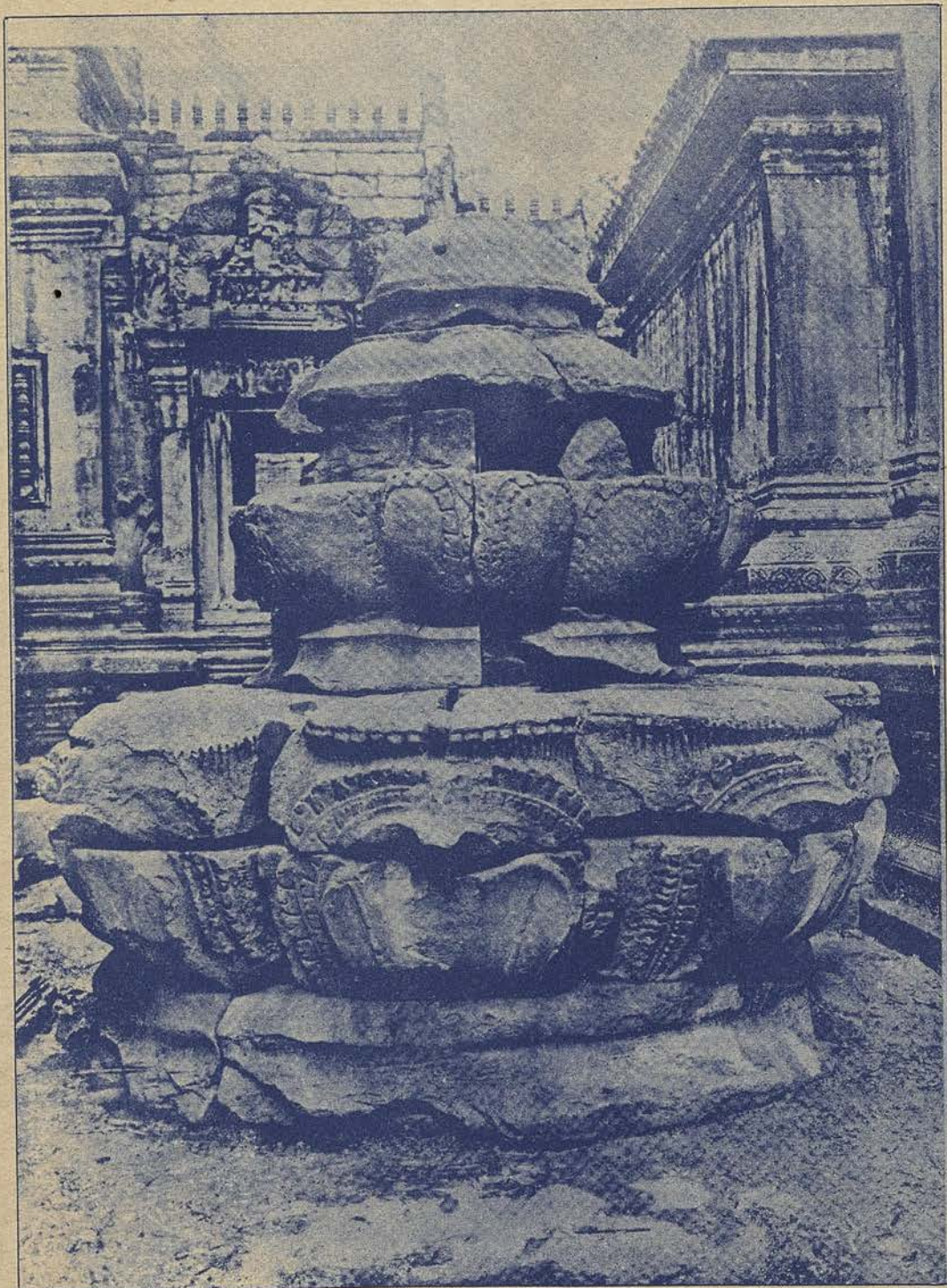
BANTAY SAMRÉ : Couronnement de la Tour Centrale reconstitué au sol
