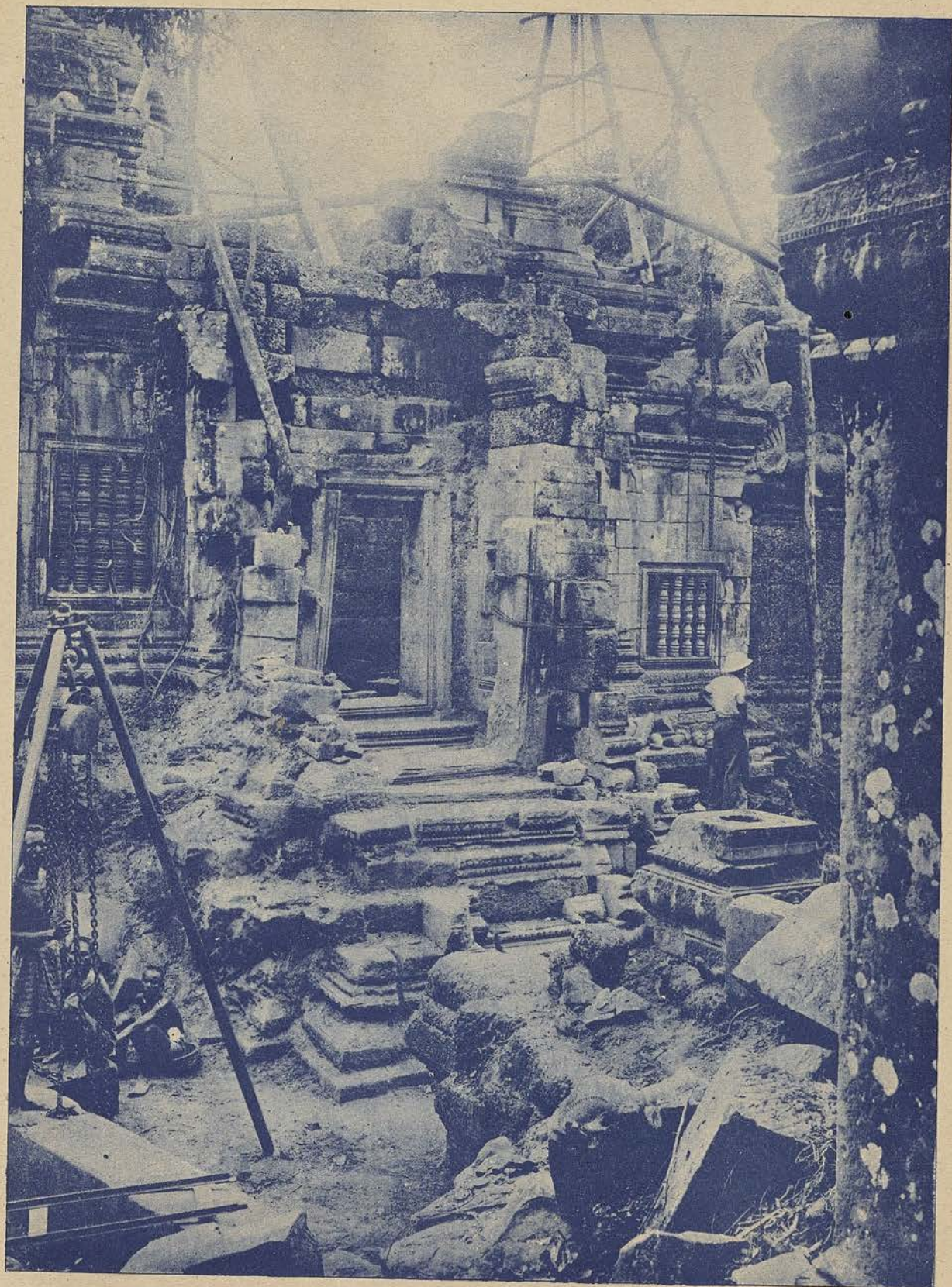
BANTAY SAMRÉ : Pavillon d'entrée Ouest après dégagement
