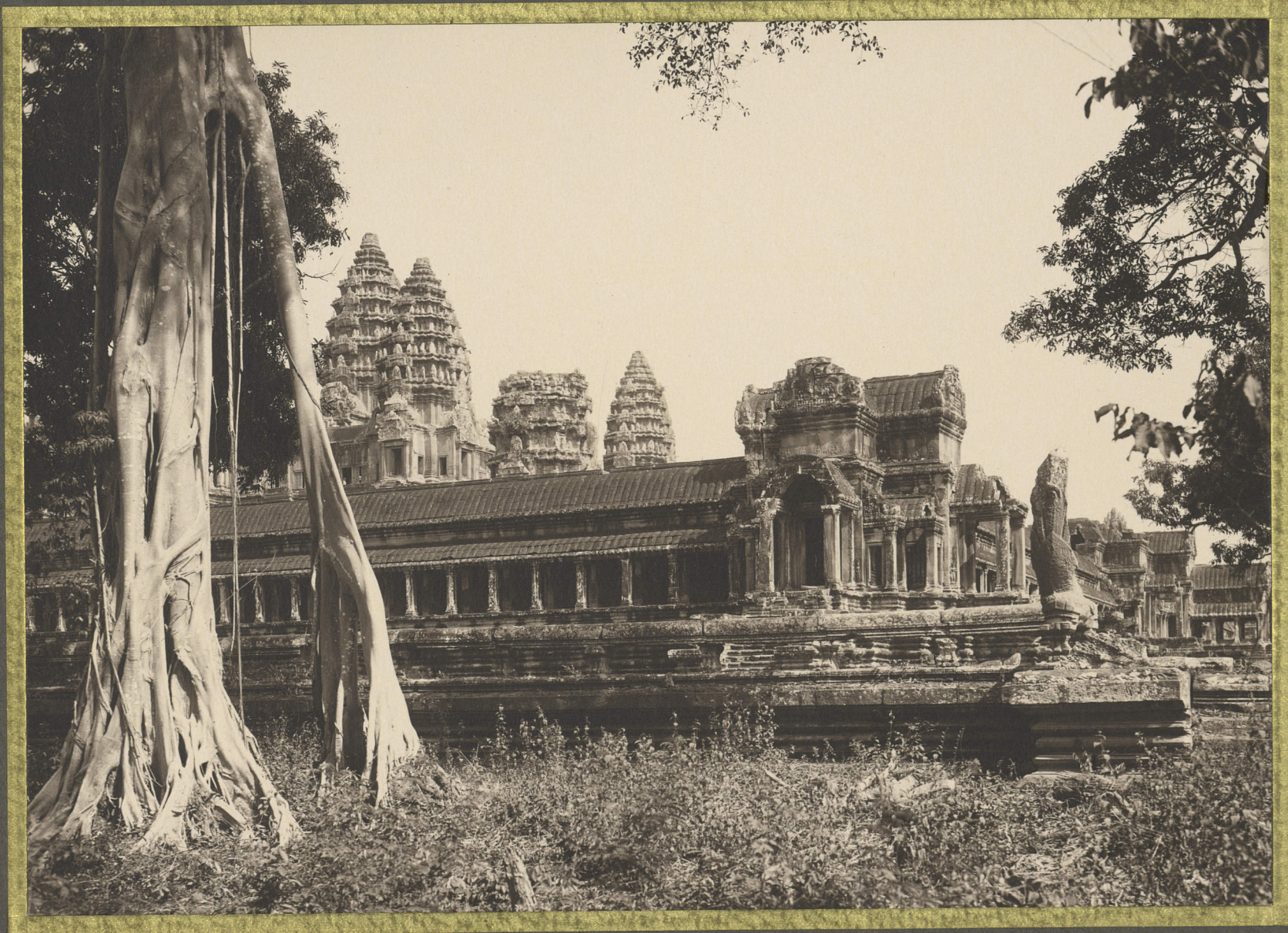
Angkor Vat. Angle Sud-Ouest. Façade extérieure.
