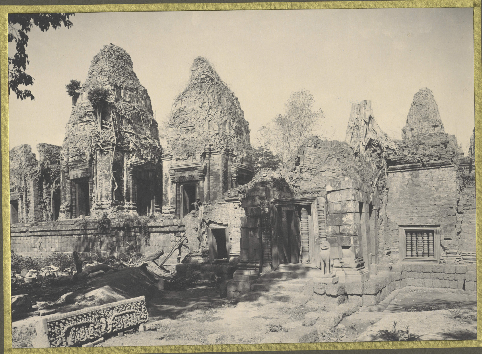
Ruines d'Angkor. Oréup. Vue générale.
