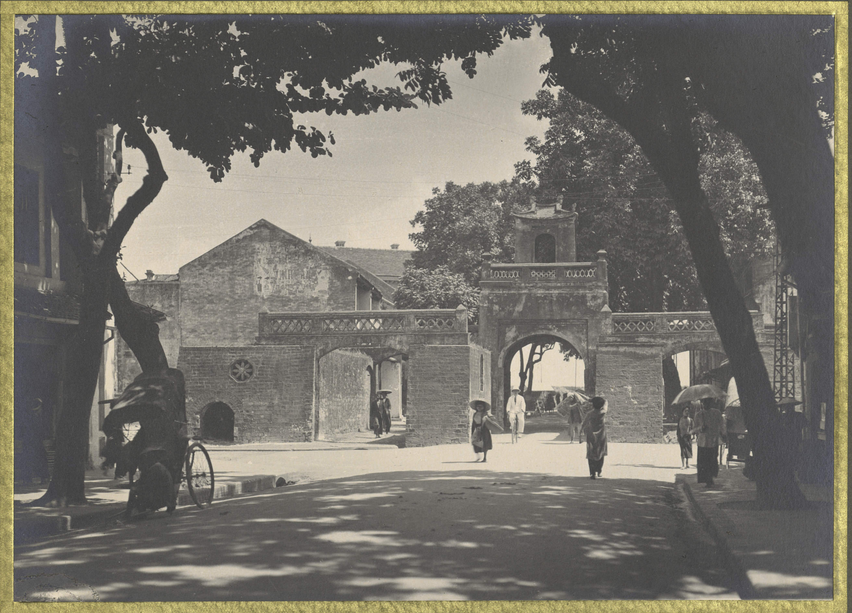
Hanoi . Le portique de la rue Jean Dupuis .
