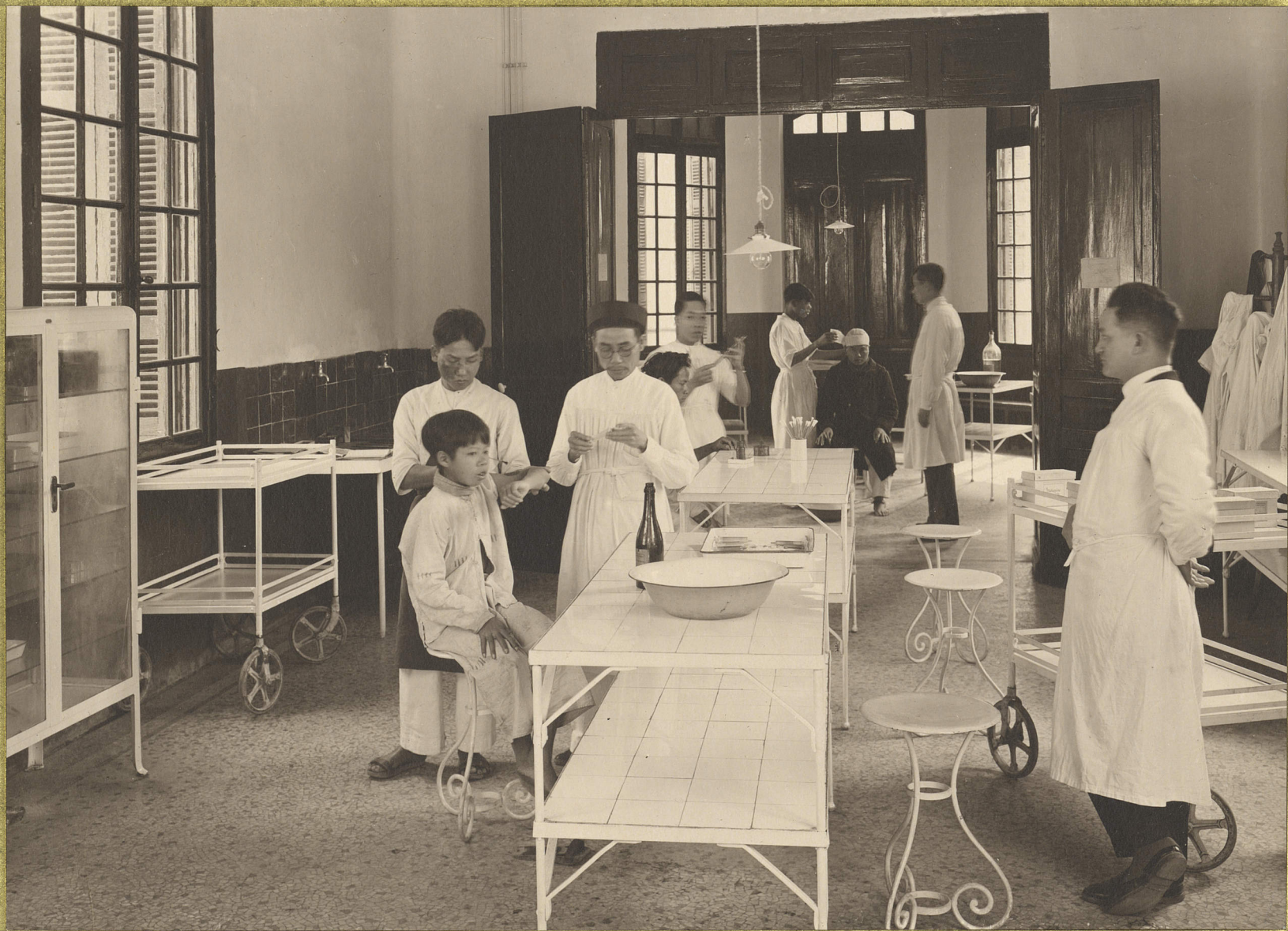
Hanoi. A l'Hôpital Indigène du Protectorat. La salle de pansements et petites interventions.
