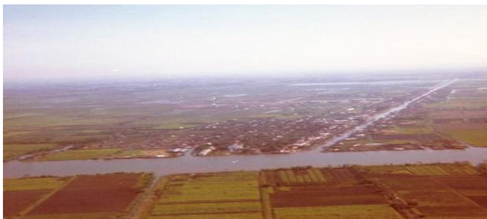
Cảnh chụp khu nhà máy đường Hiệp Hòa
