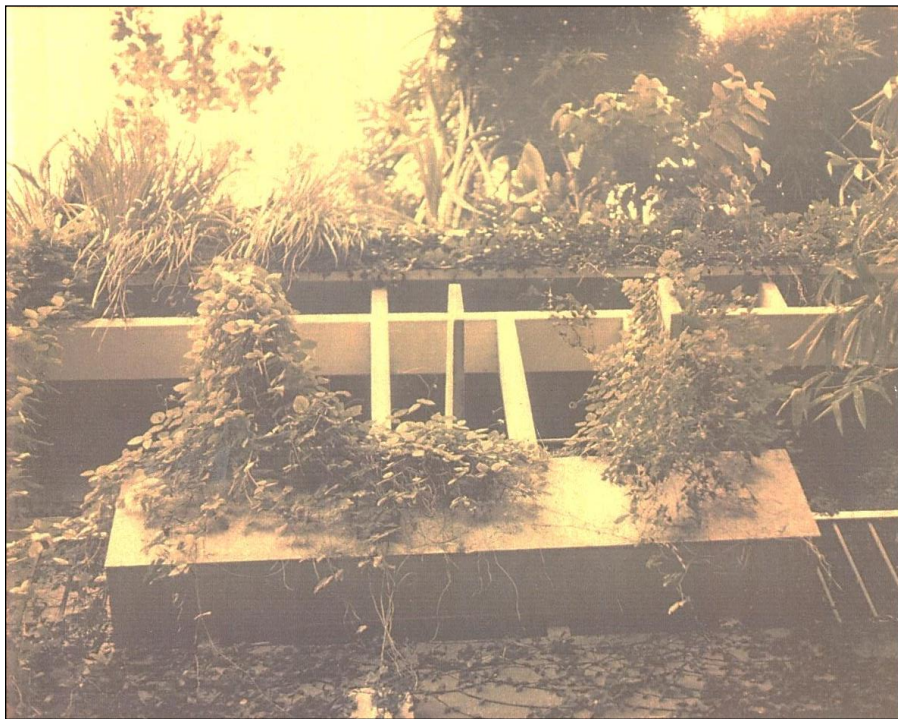
Nhìn lên lầu 2 và 3 của mặt tiền, có hàng tre cao 5 thước trên sân thượng tránh được các cửa sổ chung quanh nhà. Lá xanh trước nhà tránh được ngoài đường nhìn vào nhà
