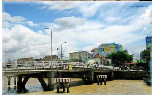
2. Cầu Quay cũ sập xây lại năm 1939
